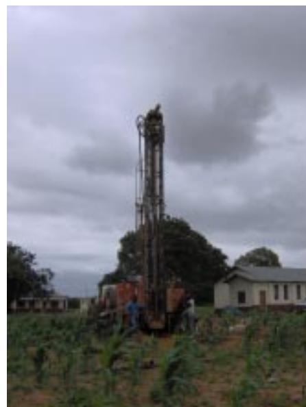
Aprofundiment del pou.
