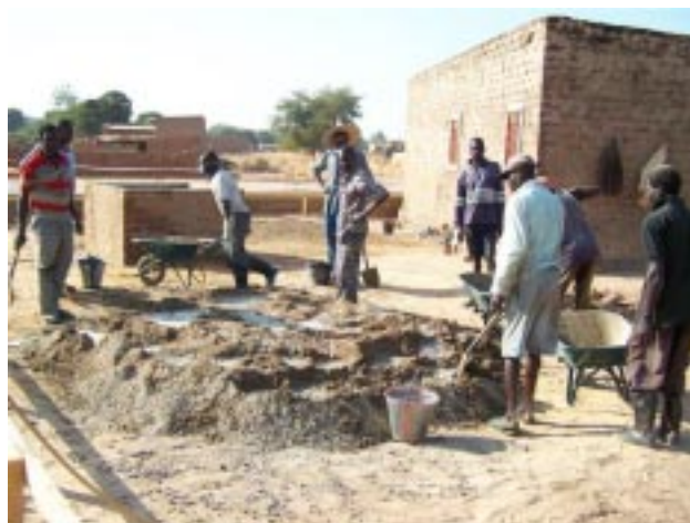
Treballs de construcció de la nova escola.
